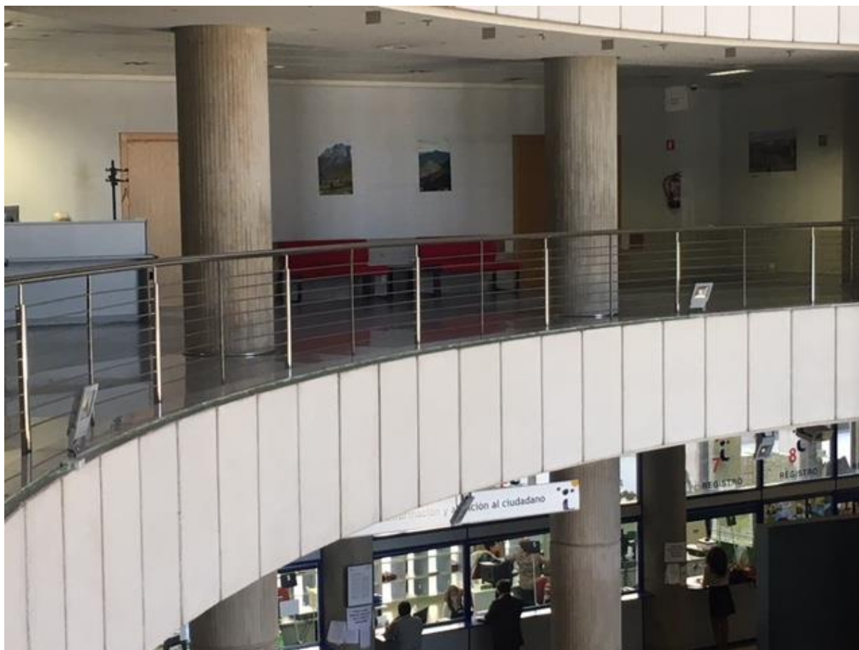
FOTO 2: Nuevos focos led en zona de vestíbulo
